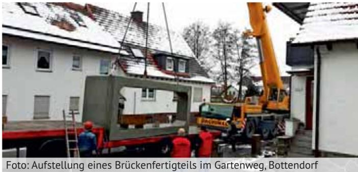
Foto: Aufstellung eines Brückenfertigteils im Gartenweg, Bottendorf
